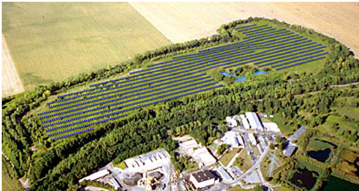
Solarkraftwerk Espenhain ( Visualisierung, Quelle: GEOSOL Berlin )
